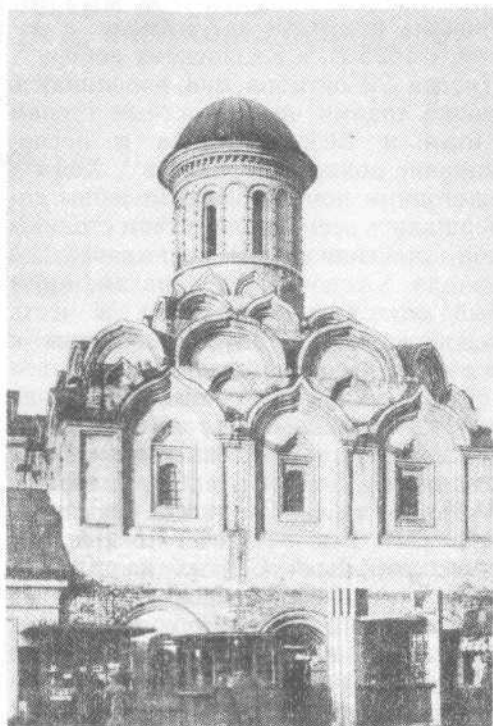
Рис. 3. Вид Казанского собора в 1936 г. перед разборкой
